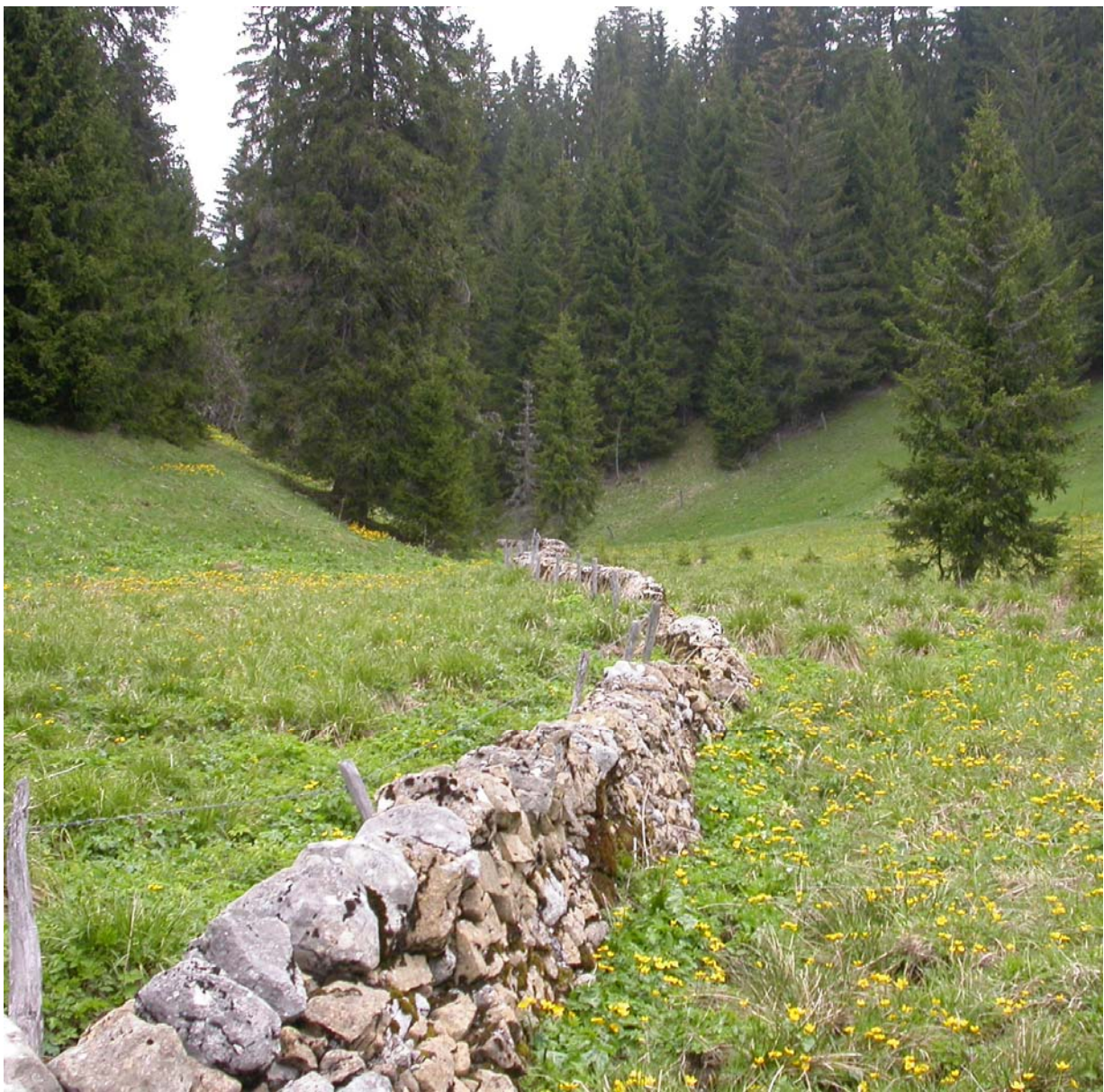
Là où naît le Biblanc. On regarde ici contre l'aval
